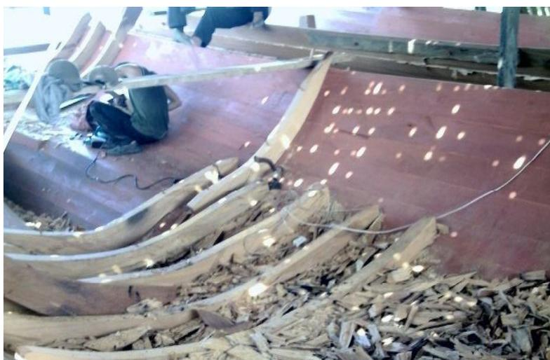
Gambar 6. Cara pemasangan gading kapal
